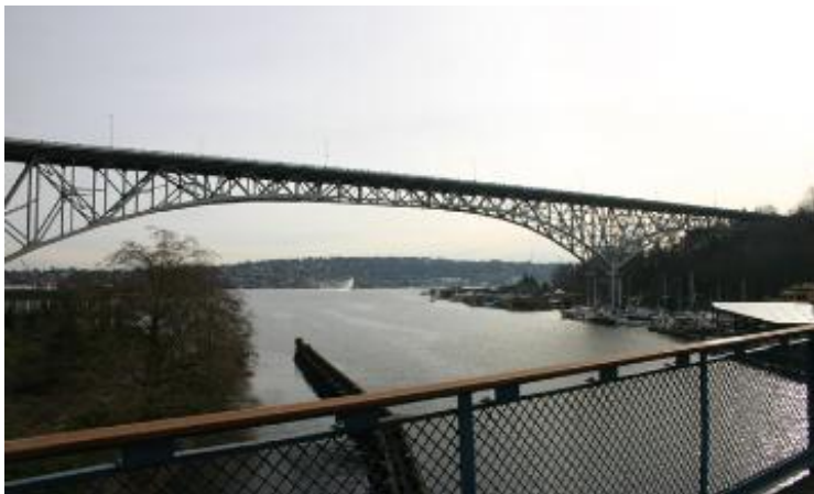
Puente de la Avenida Aurora
